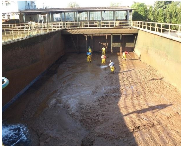
Figura 1. Limpeza de um decantador
